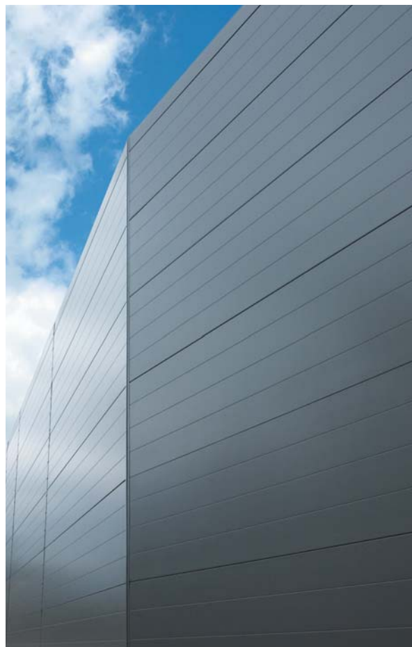
Канавковое профилирование R250. Торговый центр, Пила, Польша
